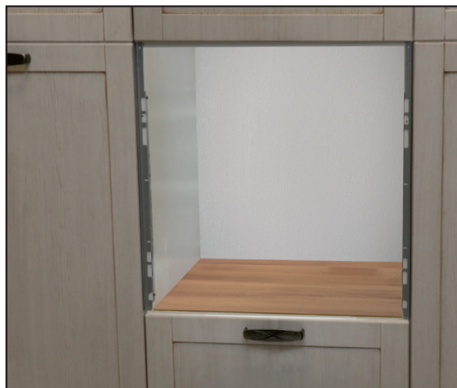
Prostor pro troubu s namontovaným tepelným štítem
